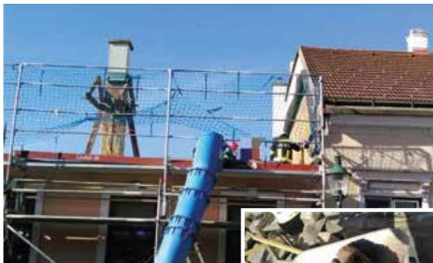
Bei Flämmarbeiten wurde die Dachfuge eines Hauses in Brand gesteckt.
